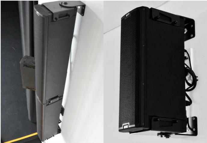
メインスピーカーはIG4Tを2台連結させてL/Rに設置。デジタルステアリング機能を実装しており、連結させたことで今回のように高い位置の壁に垂直に取り付けた場合も、手軽に指向角を下振りする事が出来ます。
